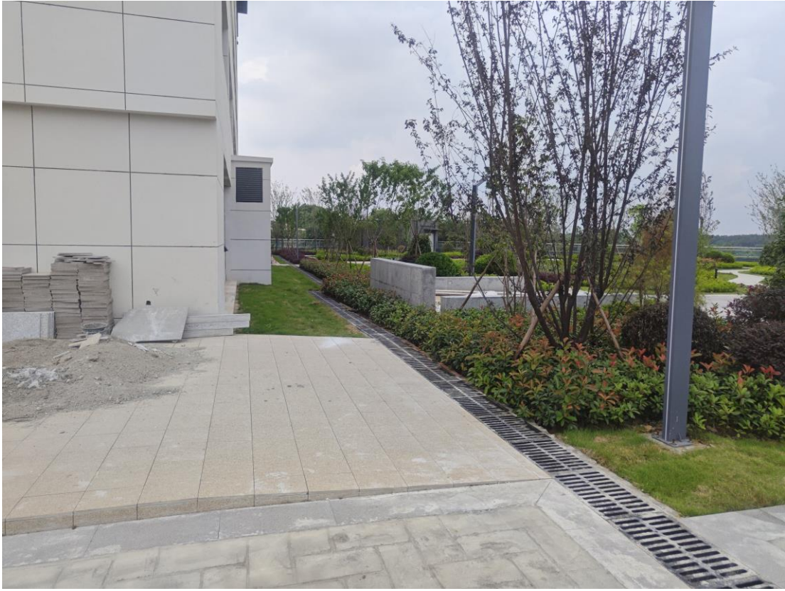
建筑周边雨水沟 (2024 年 10 月)
